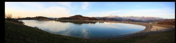
IZGRADNJA ZGORNJEGA AKUMULACIJSKEGA BAZENA ČE AVČE
